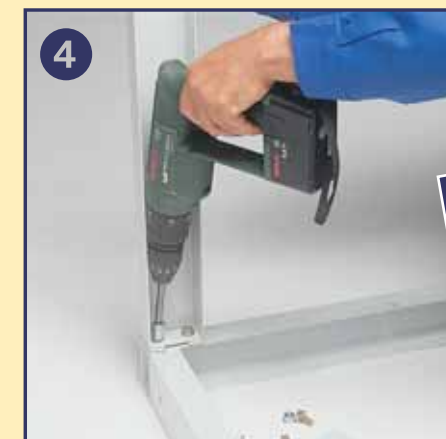
Assemblage des traverses sur échelle. Crosspieces assembly on the ladder.
