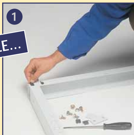
Mise en place des écrous sur échelle. Nuts fixing onto the ladder.
